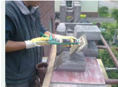
07 / Schnittflächen mit PU-Kleber verbinden.
