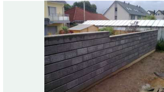
17 / Beispiel einer fertiggestellten Wand.
