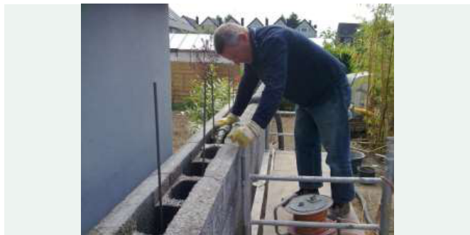
14 / Wand abschnittsweise verfüllen.
