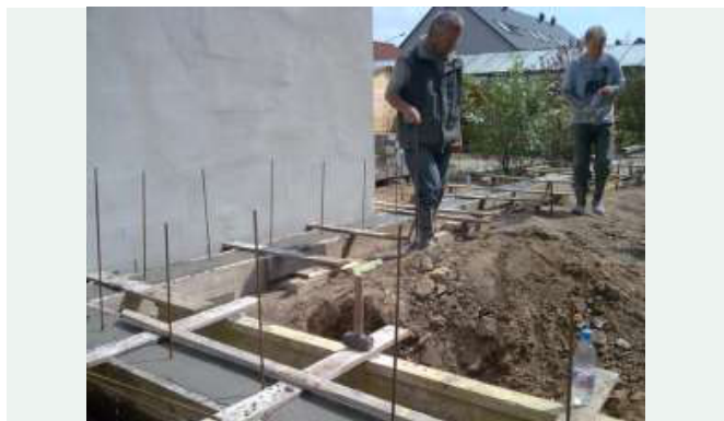
01 / Fundament mit Anschlussbewehrung.
