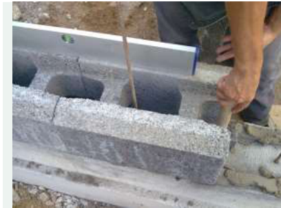
04 / Mörtel aus dem Füllraum entfernen.
