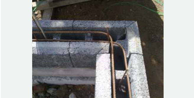
09 / Horizontale Bewehrung im Eckbereich.
