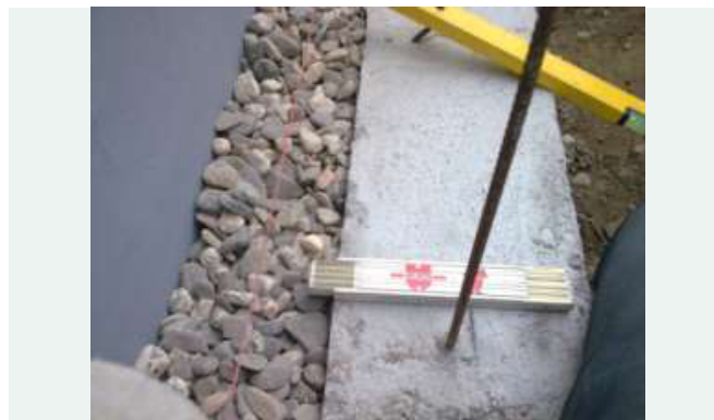
02 / Lage der Anschlussstäbe kontrollieren.
