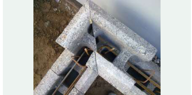
10 / Kreuzende Eckbewehrung im Füllraum.
