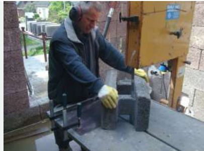
06 / Passgenauer Zuschnitt an der Bandsäge.
