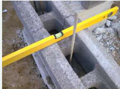
03 / Längs- und Querwaage prüfen.
